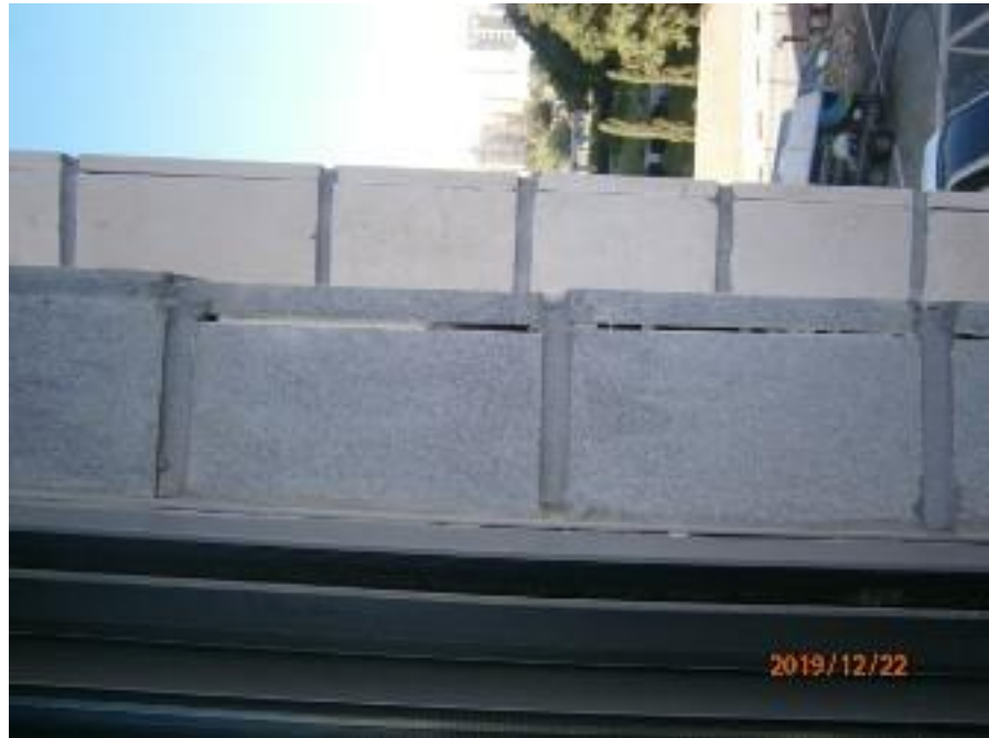
חוסר במילוי מהווה הן ליקוי באטימת מערכת החיפוי והן פגם אסתטי ומנוגד למפכ"מ 378, סעיף 105.3. ומנוגד לת"י 2378.1 לחפוי באבן טבעית, סעיף 5.3.2 ו- 5.3.3:
