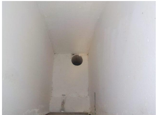
דרוש: סריקת כל ארונות התשתיות ומילוי מעברים פתוחים בחומר מעכב שריפה. עלות:
